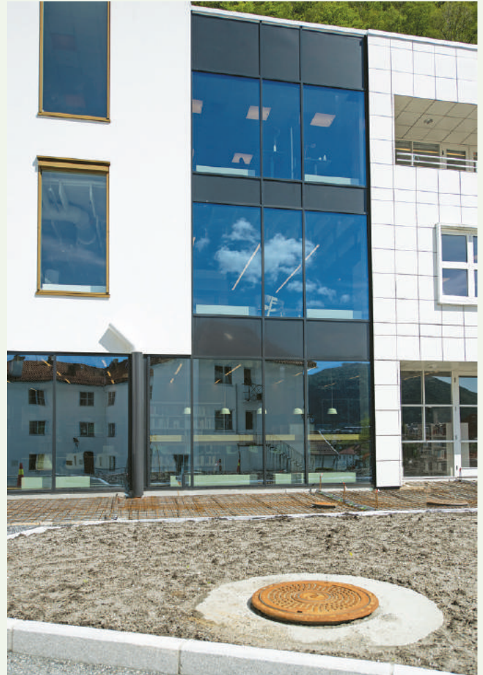
Glassfasade mellom ny og rehabilitert del.
